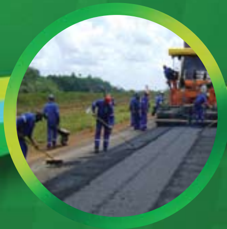
Execução da Capa Asfáltica – BR-156 • AP
